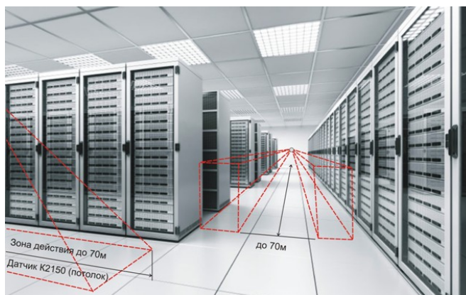
Рис. 3. Производственное здание – установка датчика K2150 на стене и на потолке
